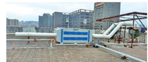
车间顶层安装活性炭过滤箱
